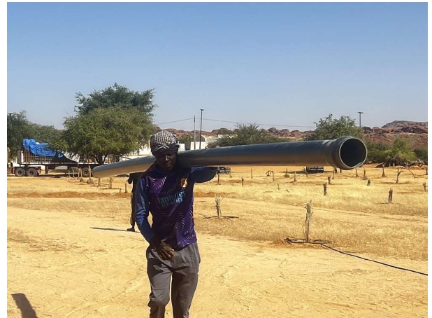
نقل مواسير الشبكة داخل الموقع بمدينة أمجرس Moving network pipes on site at Amdjarass
