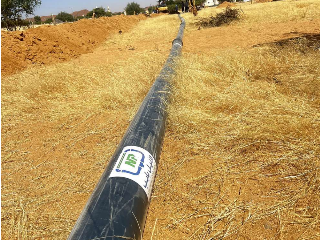
خط ناقل ممتد بموقع المشروع قبل الردم Transmission line laid along the project site prior to backfilling
