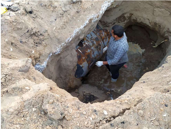
أعمال الحفر والتجهيز على الخط الناقل قبل التركيب Excavation and pipe preparation prior to installation
