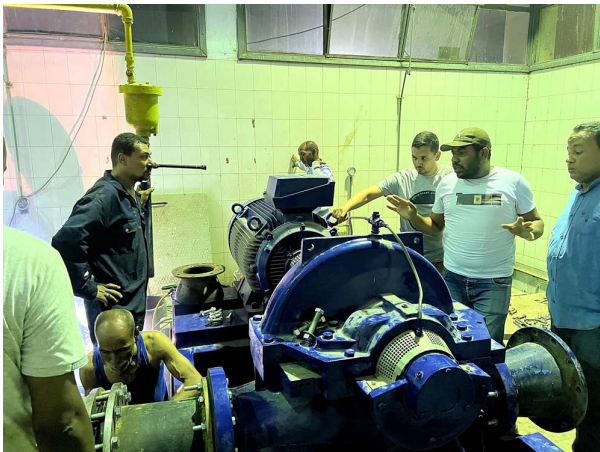
أعمال إحلال وتجديد طلمبة بجسم مشقوق Replacement and overhaul of a split-case pump
