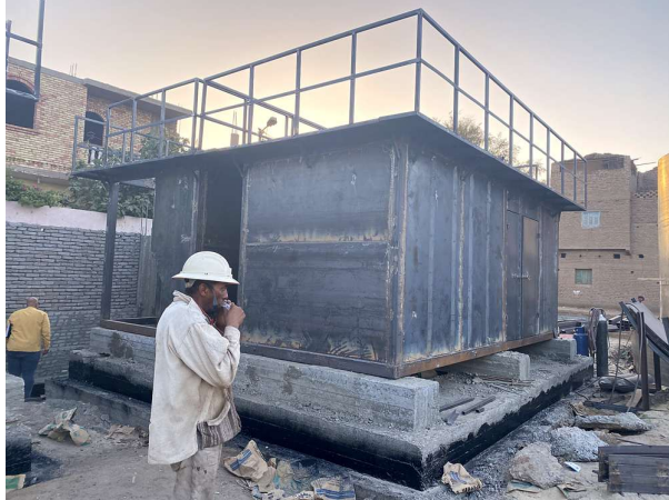
تجهيز أحواض المعالجة المعدنية أثناء التنفيذ Steel treatment basins under construction
