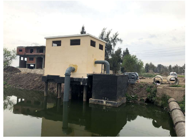
مبنى محطة الخلط الوسيط وخط الطرد على التربة Intermediate mixing station building and discharge line
