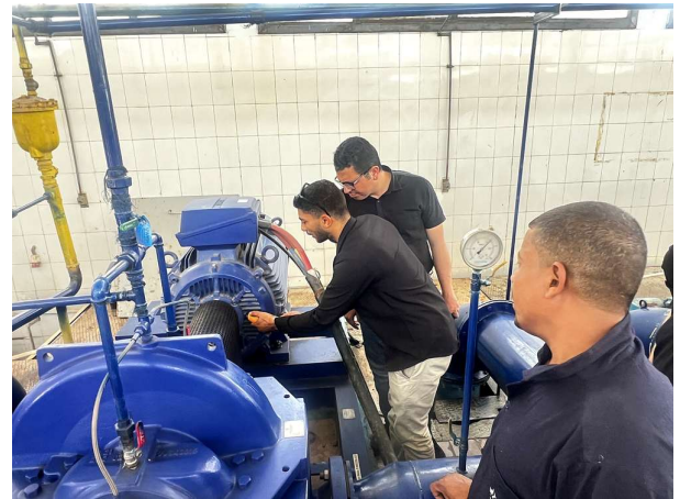
أعمال التشغيل والاختبار لمجموعة ضخ بعد التجديد Commissioning and testing of a rehabilitated pump set
