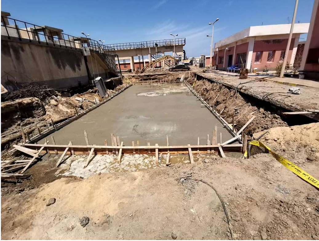
أعمال الخرسانة المسلحة لأحواض المعالجة أثناء التنفيذ Reinforced concrete works for the treatment basins during construction
