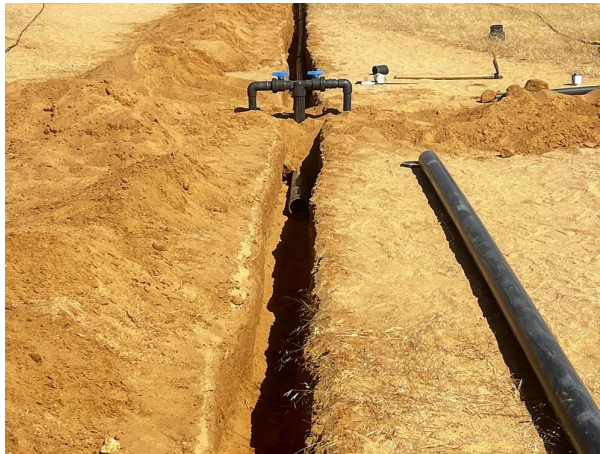
حفر الخنادق وتركيب خطوط التوزيع والمحابس Trenching and installation of distribution lines and valves
