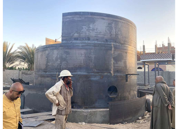
إنشاء وحدة الترويب والترسيب بالموقع Erection of the clarifier unit on site
