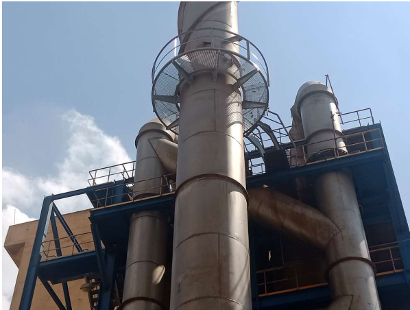
مدخنة العادم ومنصة أخذ العينات بموقع القياس Exhaust stack and sampling platform at the measurement point
