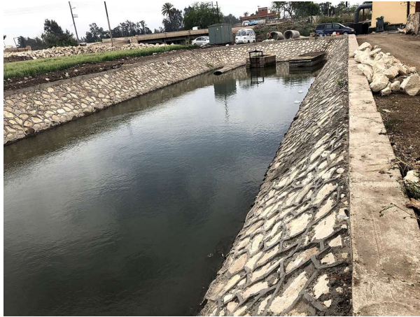
أعمال تبطين وتأهيل التربة عند مأخذ المحطة Canal lining and rehabilitation at the station intake
