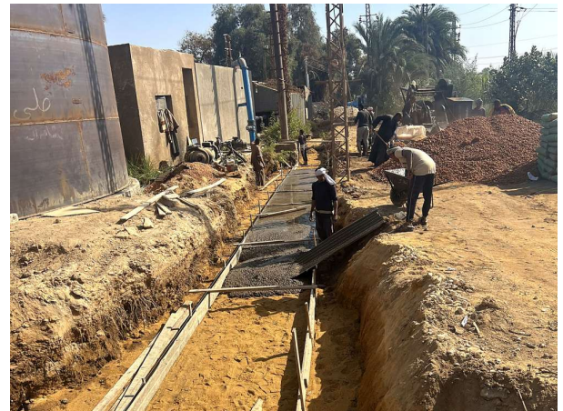
أعمال مدنية وخطوط ناقلية بموقع المحطة Civil works and transmission lines on site
